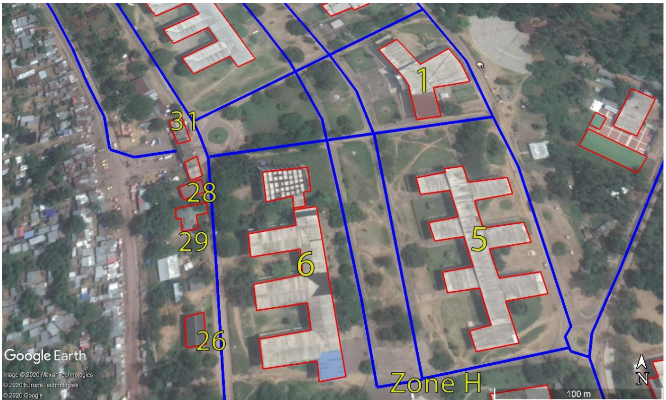
Figure 9. Zone H : Bâtiment administratif (1), Faculté d'économie et des sciences politiques et administratives (5), Faculté des lettres et de droit (6), Bâtiment doyen MATHANGILA (26), Espace biblique Universitaire (28), Salle de lecture CDS (29) et Garde Universitaire (31).
